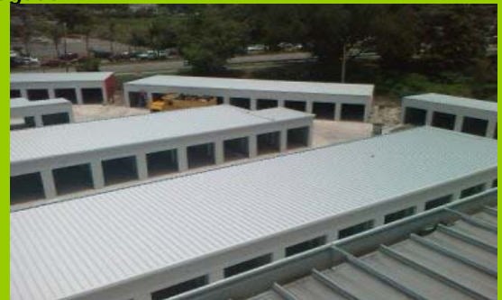
Techo sobre Mini Warehouse de Carolina
