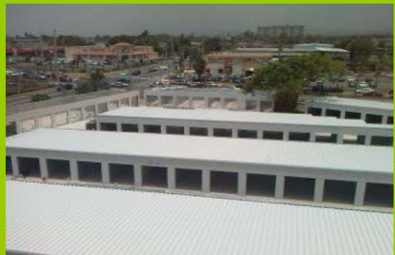
Techo sobre Mini Warehouse de Carolina
